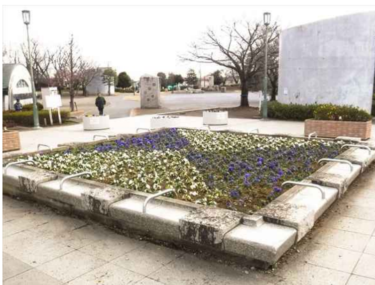
湘南台公園 花壇ベンチの手すり設置
