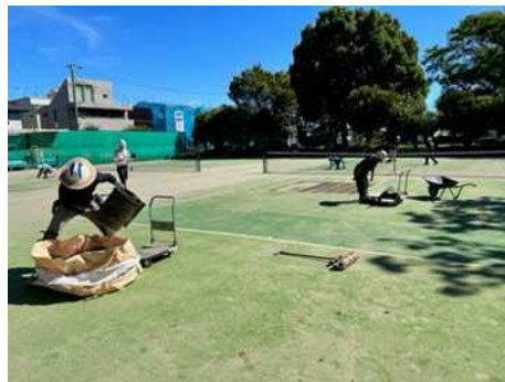
利用者の意見を反映したテニスコート人工芝の修繕状況 （湘南台公園）
