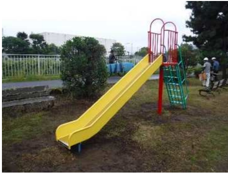
利用者の意見を反映した遊具（滑り台）交換修繕 （引地川緑道）
