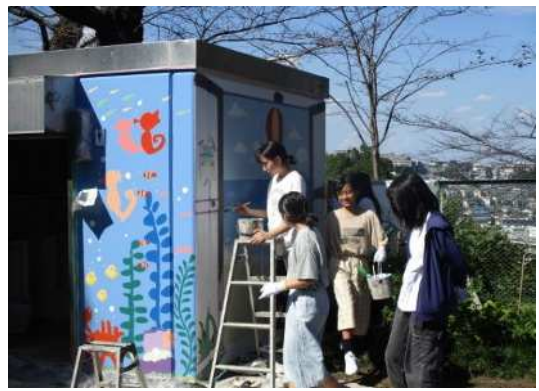
公衆トイレの外壁塗装 (伊勢山公園)
