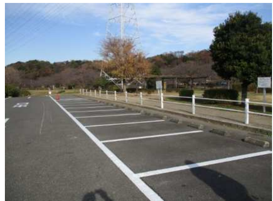
公園駐車場のライン引き直し修繕 (引地川親水公園 右岸)
